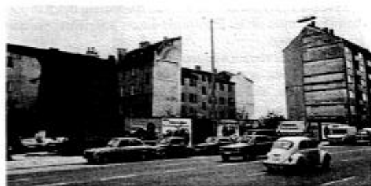
Bild 1. Baulücke an der Rosenheimer Straße
