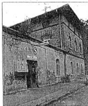
Heruntergekommen war das Bahnhofsgelände vor der Sanierung. Foto: Schunk
